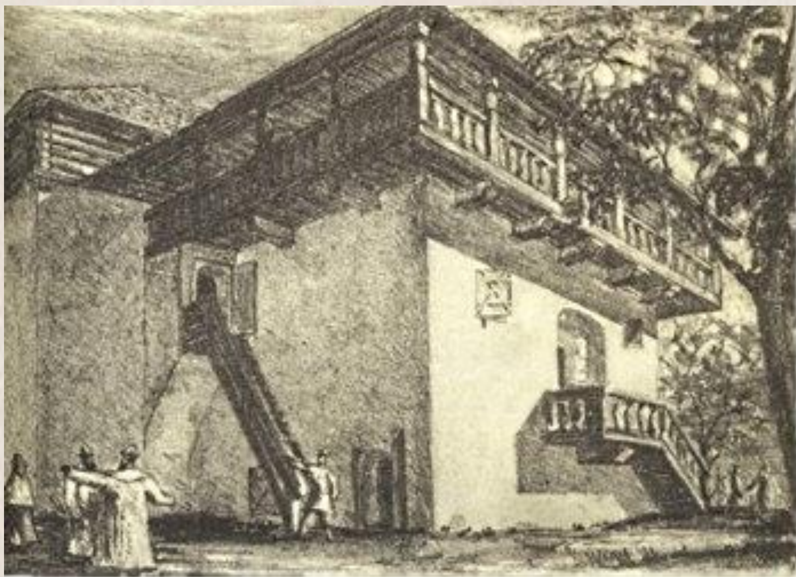
Двор Трубинских Реконструкция Ю. П. Спегальского
