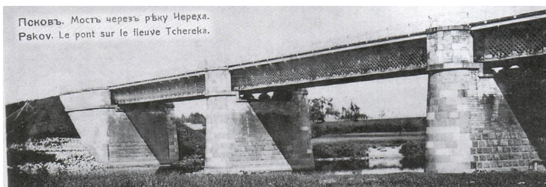
Мост через реку Череха. Фото конца XIX в.
